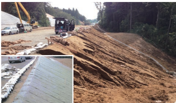
道路工事 <法面植栽用の基盤>
