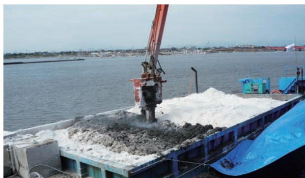
橋脚補強工事 <下流のノリ養殖への配慮>
