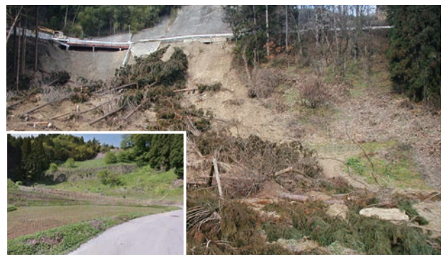
災害復旧工事 <周辺農地への配慮・復旧後植栽>
