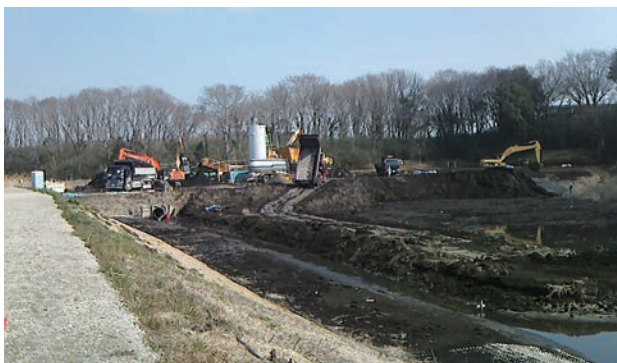
調整池浚渫工事 <周辺河川・農地への配慮>
