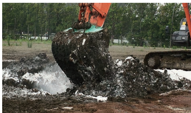
土壌汚染対策工事 <不溶化処理後の要中性の地盤改良>
