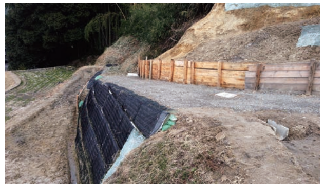
農道復旧工事(路体) <周辺圃場への配慮>
