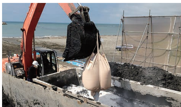
港漁施設機能強化工事 <改良状況>
