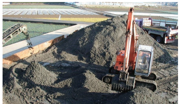
公園整備工事 <湖沼浚渫土改良状況>
