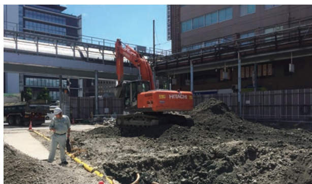
マンション新築工事 <改良当日に場外搬出>
