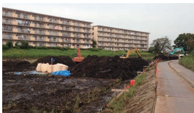
調整池浚渫工事 <浚渫土養生場所不足の為>
