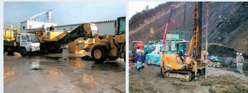
実機を用いたフッ素汚染土壌不溶化処理
