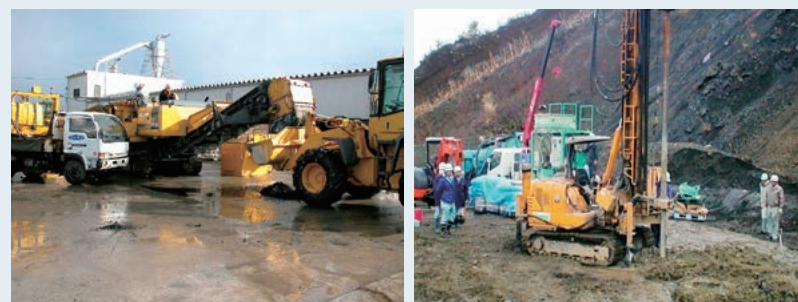
実機を用いたフッ素汚染土壌不溶化処理
