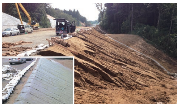
道路工事 ＜法面植栽用の基盤＞
