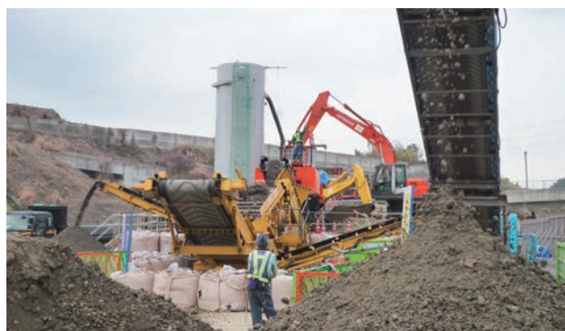
廃棄物混入土砂分別工事 ＜前処理の改質材として使用＞
