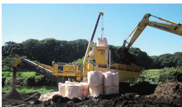
河川浚渫工事 ＜改良土保管場所条件が中性＞
