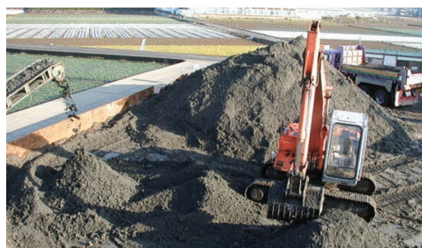
公園整備工事 ＜湖沼浚渫土改良状況＞
