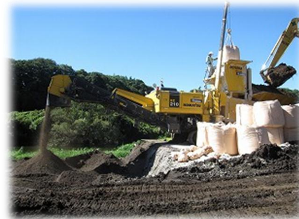
千葉県 河川の浚渫工事 浚渫改良状況
