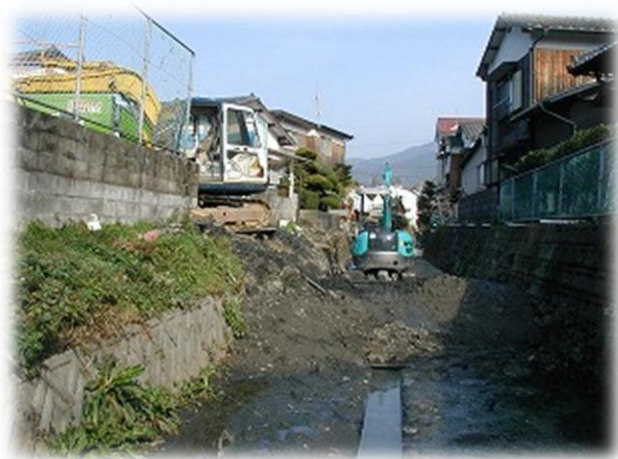
改良土使用場所の制約による採用事例 汚泥集積状況
