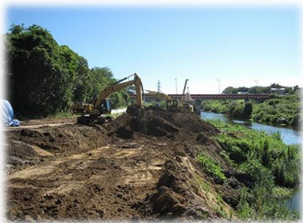
河川の浚渫工事の採用事例 浚渫工事状況
