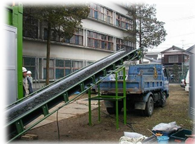
愛媛県 環境土木緊急処理工事 改良土搬出状況
